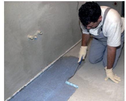
PCI Gisogrund schützt Ausgleichsspachtel und Dünnbettmörtel vor zu schnellem Wasserentzug, verlängert die klebeoffene Zeit, verbessert die Haftung und vermeidet die Bildung von Schwundrissen.
