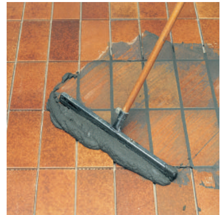
PCI FT Fugenbreit bündig in die Fugen einbringen. Oberfläche sauber abziehen ...
